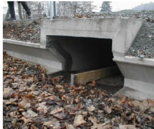
Pilt 4.1, Kahepaiksetele sobivaim betoondetailidest tunnel - joonis 10, lk 18, Astangu kahepaiksete ja roomajate rohevõrgustiku sidususe analüüs, (foto Lars Briggs)
