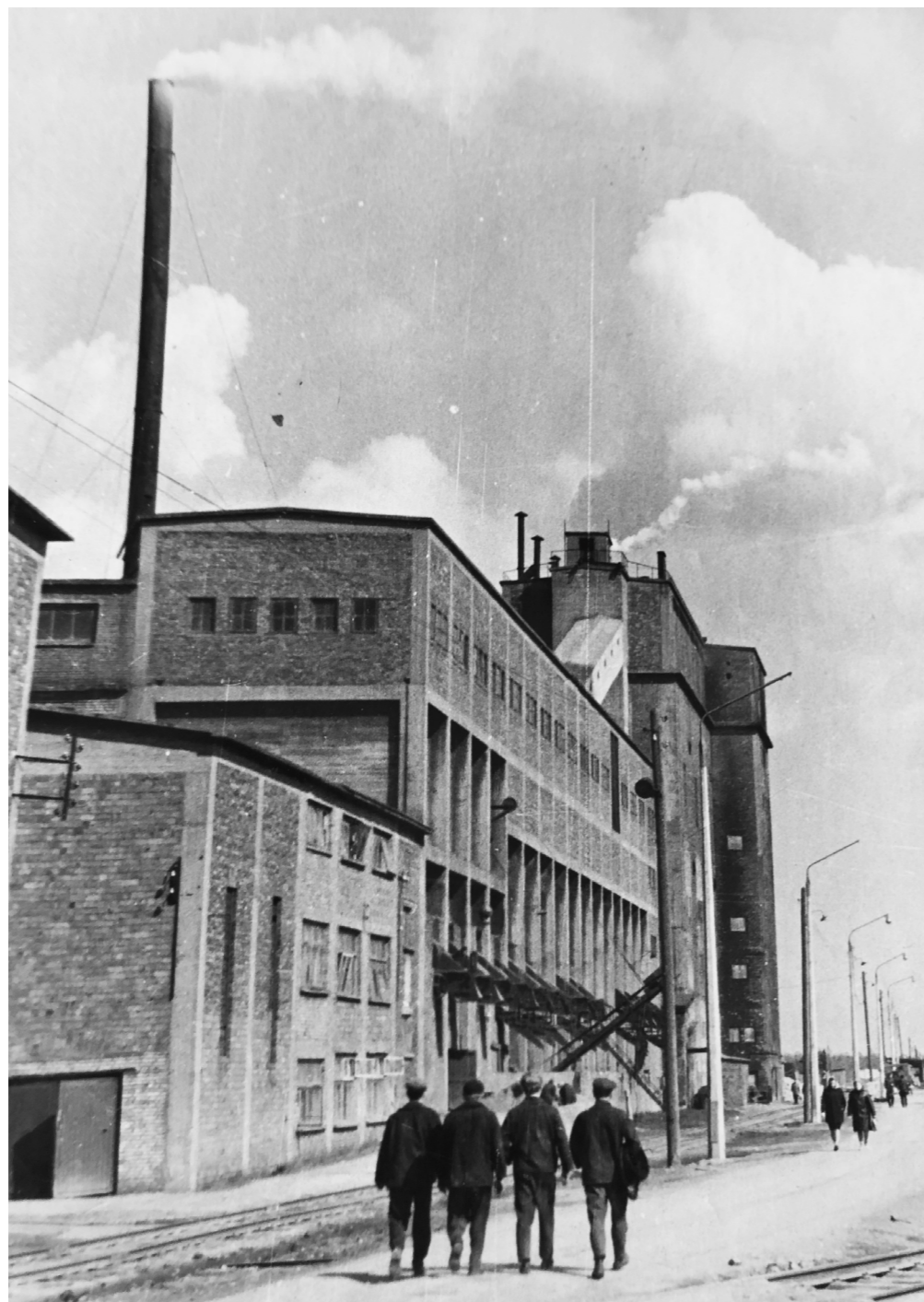
Illustratsioon 43. Vaade Kiviõli keemiatööstuse generaatori hoonele. Allikas: Keemiatööstuse fotokogu.
