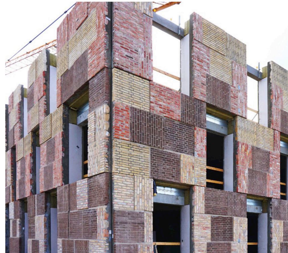
Illustratsioon 22. Resource Rowsi hoone fassaad, milles on kasutatud tehaste ning koolide seintest välja lõigatud tellisemooduleid. https://lendager.com/arkitektuur/ressourceraekkerne/
