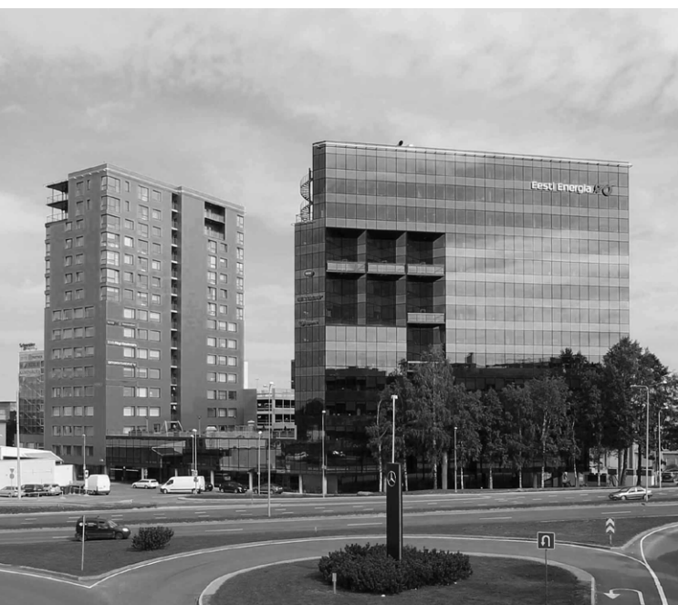
Pilt 6-3. Eesti Energia hoone, Lelle 22 ja 24 58
