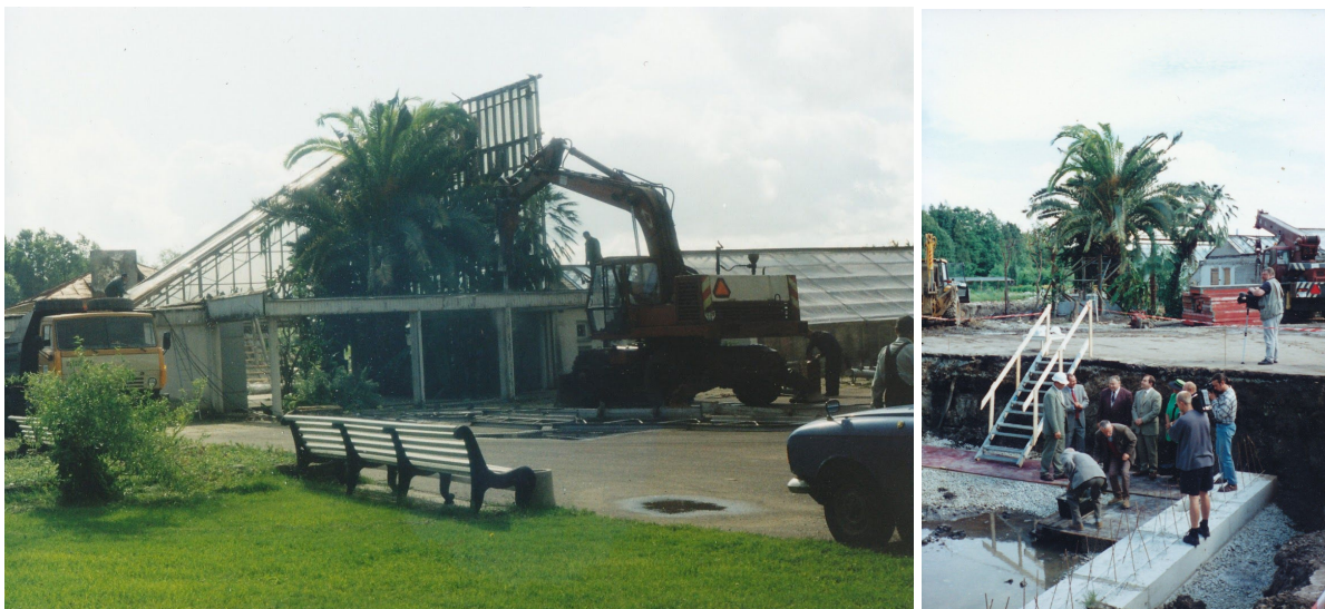
Illustratsioon 8: Vasak pilt: V. Pormeistri hoone lammutamine. Foto keskel Puki Palm. Parem pilt: Künnapu ja Padriku projekteeritud hoone nurgakivi panemine. Eemal taustal kasvupinnases kasvavad taimed. Tallinna Botaanikaiaia fotokogust
