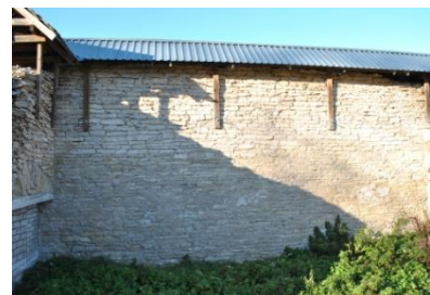
Palmimaja läänepoolne sisnurk – müüritis on konserveeritud ning varemed on katustatud. (2018-11-04)
