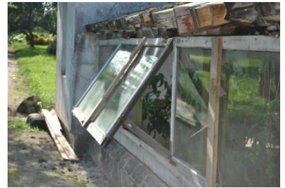
Õhutusaknad kasvuhuone lõunaosas. (2018-09-08)
