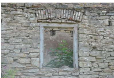
Säilinud on aednikumaja avatäide puidust lengid ja osa sepistest. (2018-08-11)
