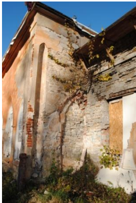
Läänepoolseima eenduva hoonemahu idaseinas asub kinnimüüritud teravkaarne ava. (2018-11-04)
