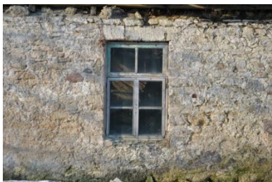
Aken põhjafassaadil, hoone lääneosas. (2019-03-30)
