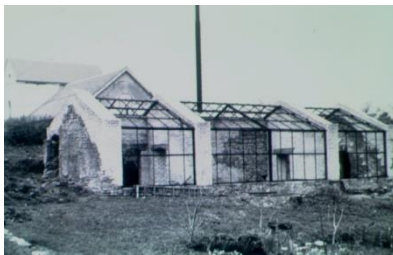
Sagadi mõisa triiphoone taastamine, eristatavad säilinud paekivist müüritised ja uus plokkidest laotu. (Sagadi mõisa kogu)
