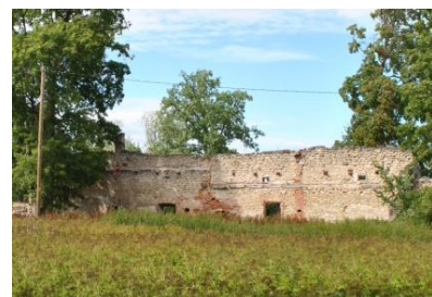
Vaade lõunast. Aednikumaja seinal on säilinud kasvuhooone talaugud ja ematala. (2018-08-11)
