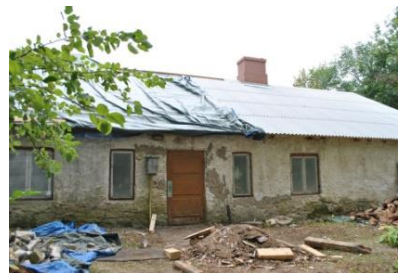
Vaade loodest aednikumaja sissepääsule. Pooleli on katusetööd. Laotud on uus punastest tellistest korsten. (2018-08-11)
