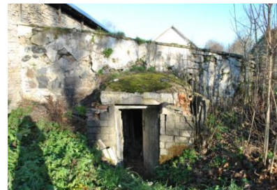
Sissepääs keldrisse läänest. (2018-11-04)
