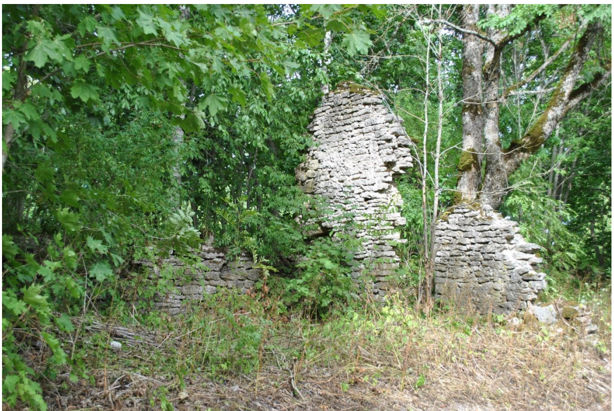
Vaade Seidla mõisa kasvuhuonele läänest. (2018-08-11)
