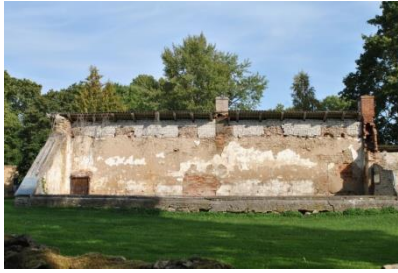
Kasvuhoone läänetiib, vaade lõunast. Ühe pääsuga põhjapoolsesse mahtu. (2018-09-08)
