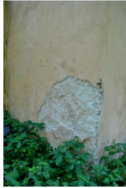
Nõukogudeaegse ülekrohvi alt paljandub säilinud ehitusaegne lubikrohv. (2018-09-08)
