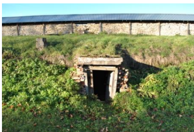
Sissepääs keldrisse lõunast. (2018-11-04)
