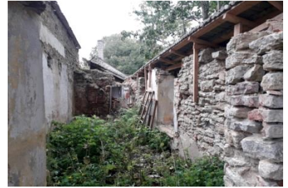
Vaade kasvuhoone läänetiiva põhjaosas painevale hooneosale idast. (2018-08-26)
