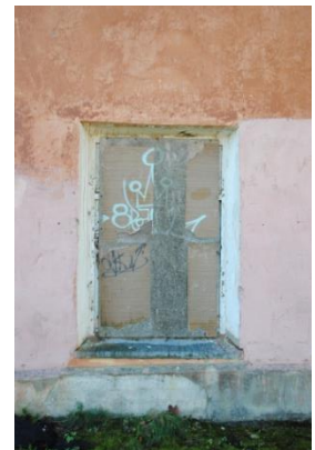
Ehitusaegne ava ja eenduv sokkel hoone põhjaseinas. (2018-11-04)
