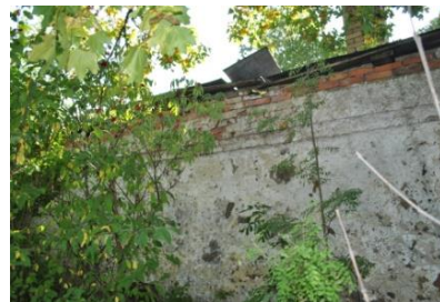
Lääne poolne korsten on laotud paest. Korstnal on säilinud vana krohvi, mis märgib kasvuhoone ehituaegset kõrgust. (2018-09-08)
