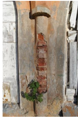
Tellistest laotud liseen läänepooleimal eenduval hoonemahul. (2018-11-04)
