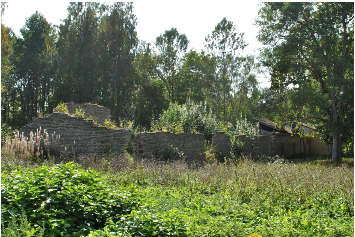
Vaade Kolga mõisa läänepoolsele kasvuhoonele põhjast. (2018-09-08)
