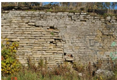
Kasvuhoone tagumine sein on osaliselt laotud silikaatkivist (2018-11-04)
