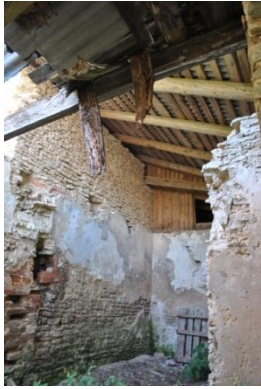
Aedniku eluruumide kõrval, hoone põhjapoolisel mahul, on katuse jupp sisse varisemas, mis põhjustab oma raskusega veelgi ulatsulikumat müüride varisemist. (2018-09-08)
