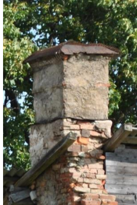
Varasem punastest tellistest korsten, korstnapits on krohvitud ja kaetud plekiga. (2018-09-08)
