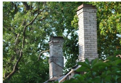
Lääne poolne korsten on laotud paest. Korstnal on säilinud vana krohvi, mis märgib kasvuhoone ehituaegset kõrgust. (2018-09-08)
