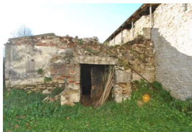
Sissepääs keldrisse idast. (2018-11-04)
