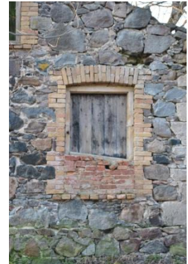
Osaliselt kinni müüritud ava põhjas, tellistest sillus ja aknalaud. (2019-03-30)
