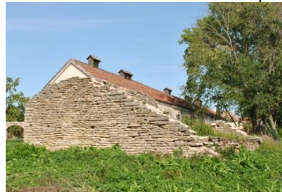
Vaade edelast kasvuhoone läänepoolsele otsaseinale. (2018-09-08)
