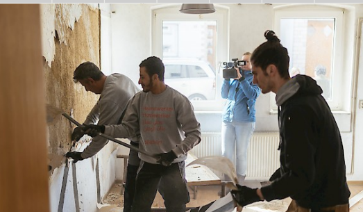
3. etapp: hoone renoveerimine
