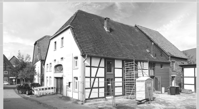
Heimatwerker projekti käigus valminud kogukonnahoone
